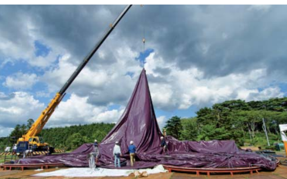
La membrana elastica di Ark Nova, fissata alla zavorra, prima del gonfiaggio.
