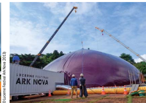
Posizionati i tubi per pompare aria all'interno della membrana, iniziano le operazioni di gonfiaggio.
